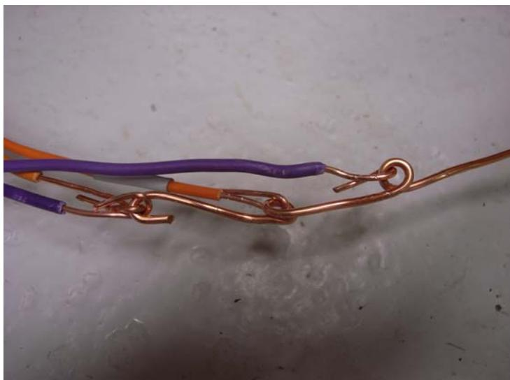
Les fils sont dénudés et passés dans des boucles du tire fil, ici un jaune vert en 2,5 mm<sup>2</sup> à droite de la photo.
