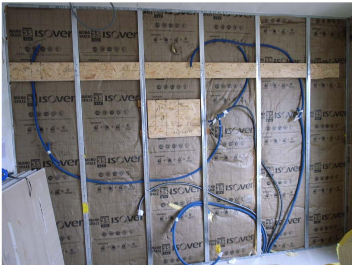
On voit sur cette photo comment sont placées les gaines avec leur point d'arrivée. Le BA13 a été percé à la scie cloche peu avant la fixation des plaques en fonction d'un plan précis.
