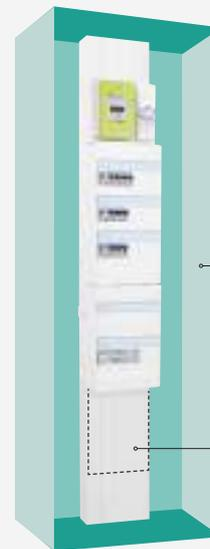
L'ETEL définit un volume strictement réservé au disjoncteur d'abonné, au tableau électrique et au coffret de communication, ainsi que tous les départs et arrivées des circuits de puissance et des réseaux de communication. Ce volume est destiné à contenir la GTL.
