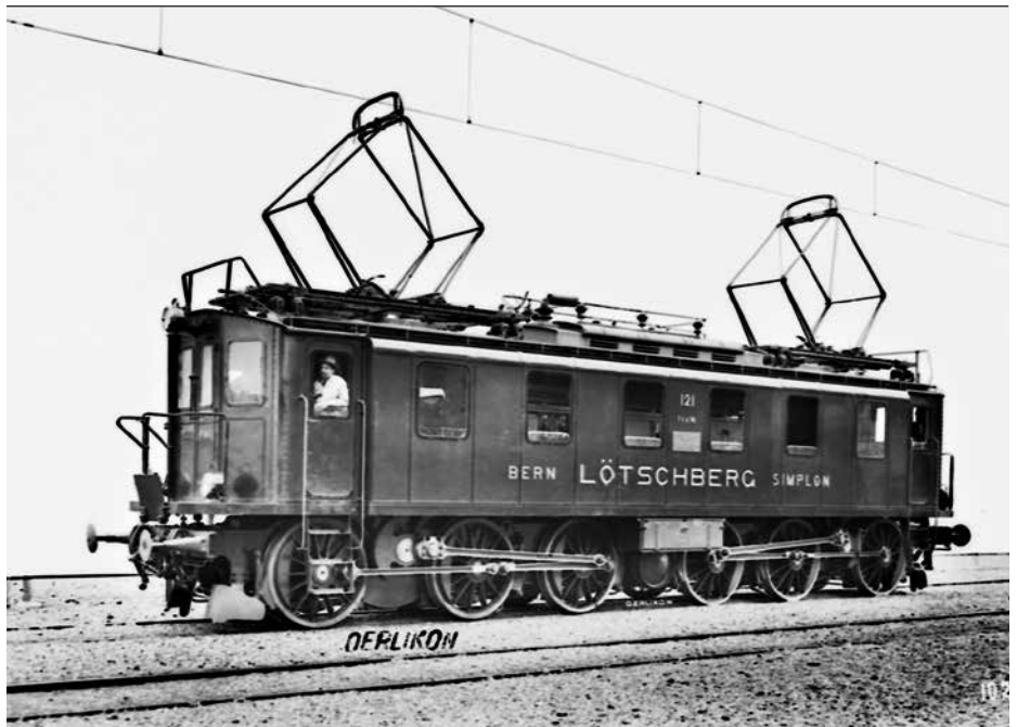
7 Locomotive d'essai des chemins de fer du Lötschberg (1910)
