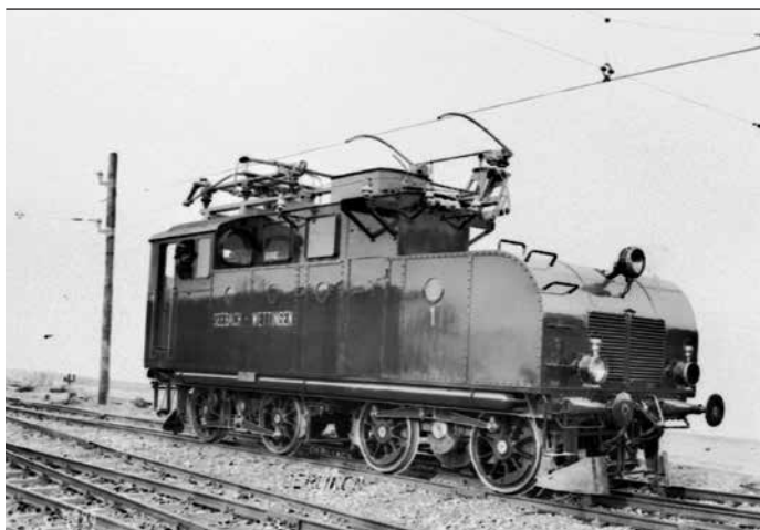
3 Première locomotive d'essai Oerlikon à groupe tournant et moteurs de traction à courant continu
