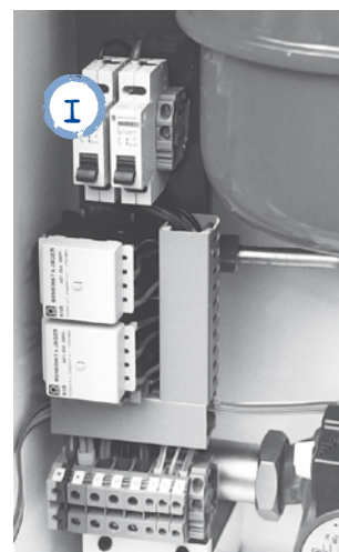
Circuit de puissance de la deuxième allure de chauffe (6 kW)
