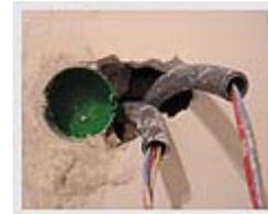
Fig. 13 - Deux conduits ICTA encastrés dans une cloison.
