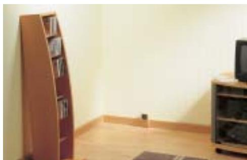
■ Dans le cas de goulottes posées en plinthe, le conducteur isolé situé le plus bas doit se trouver à 1,5 cm au moins au-dessus du sol fini.
